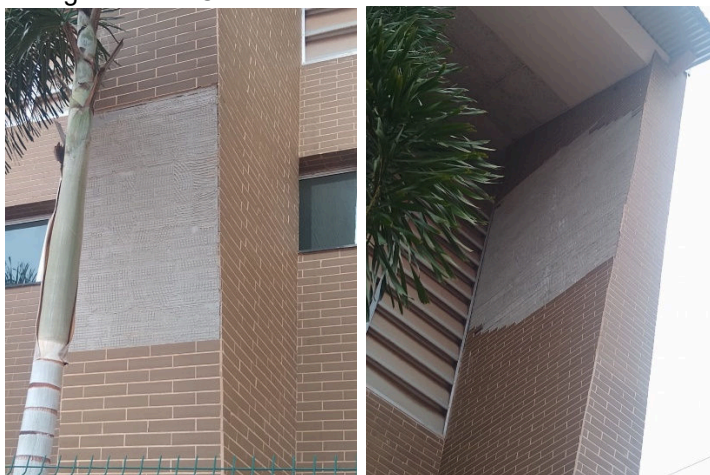
Fachada Lateral do Ginásio
