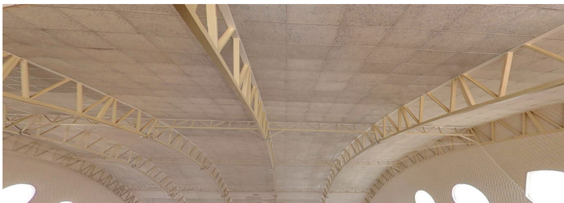
Sistema de Isolamento em forro de placa existente.
