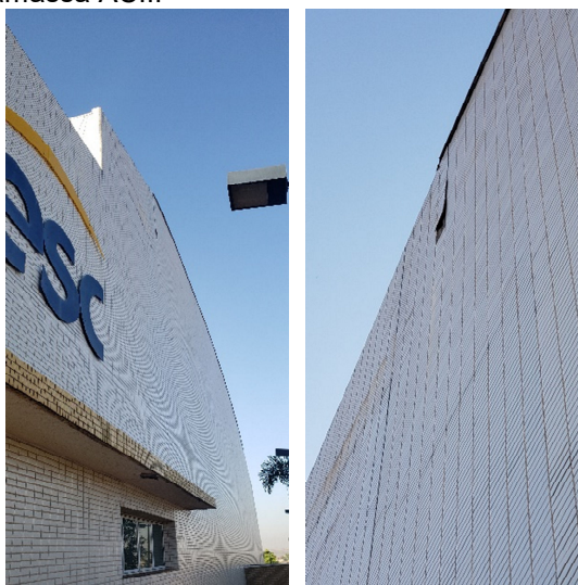
Fachada Lateral do Ginásio
