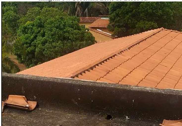
Imagem 04: Cobertura Leste do Bloco A.
